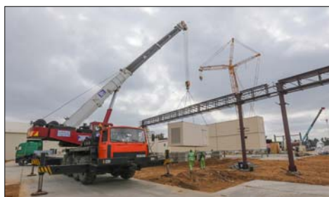
С кредитной поддержкой Беларусбанка реализуется строительство ИООО «Славкалий».
